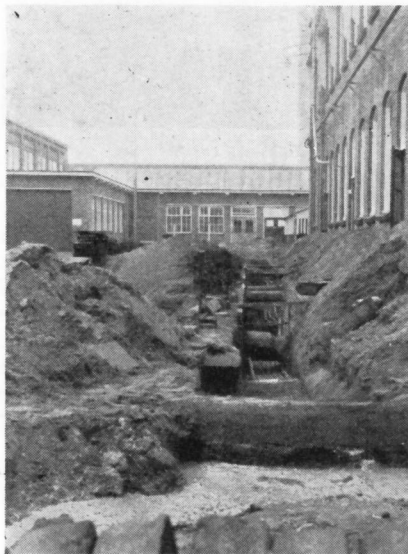
De kabelgoot voor het verleggen der kabels
