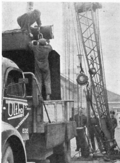
Het afladen van de step up-transformator
