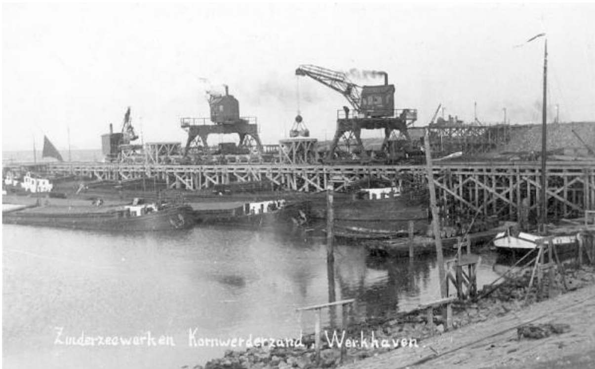
Foto 9: de kranen op de lossteiger
