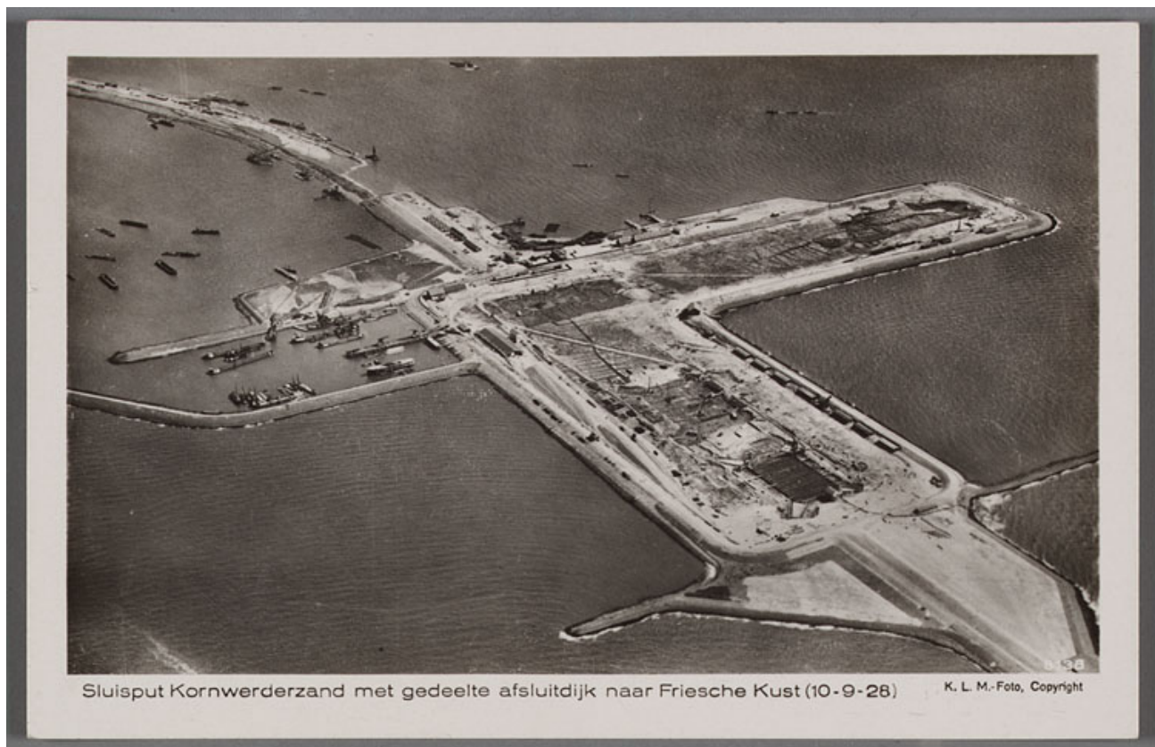
Foto 7: aanleg Kornwerderzand 10-9-1928 (Bebouwing vordert)
