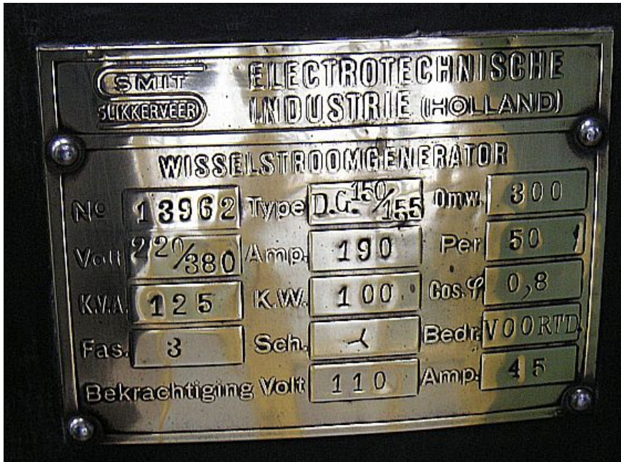
Foto 1: Type plaatje van onze generator.
